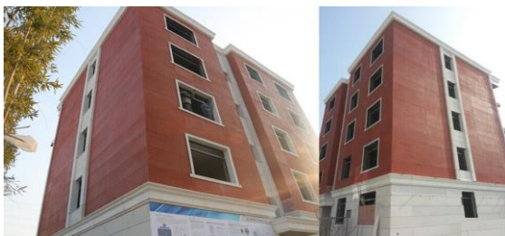
Рис.2. Один із десяти будинків надрукованих на 3D принтері компанією WinSun, Китай, 2014 р.
