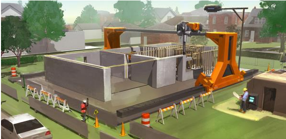
Рис.1. Схематичне зображення будівельної площадки із 3D принтером з екструдером.
