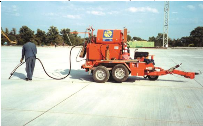
Рис.2. Заливка мастики в Аеропорту «Бориспіль» [2]
