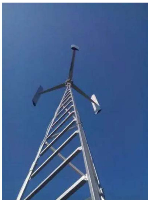
Зображення 3. Приклад встановлення на трикутній щоглі.
